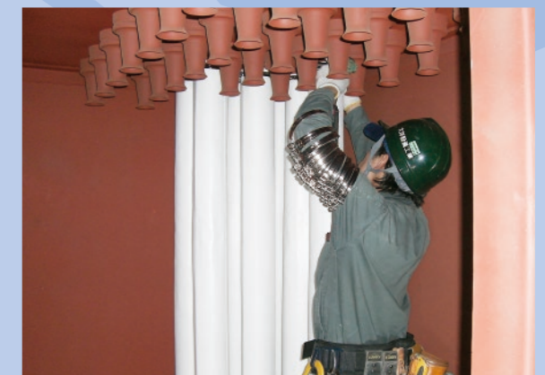
破碎機用パルス 集塵機フィルター取付工事
